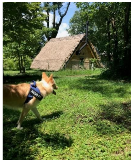
茅葺き小屋を建てました
