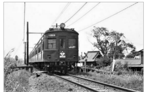
電化されたころの横浜線
