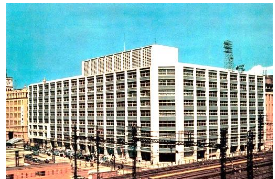
2001年リニューアル前の 新大手町ビルヂング
